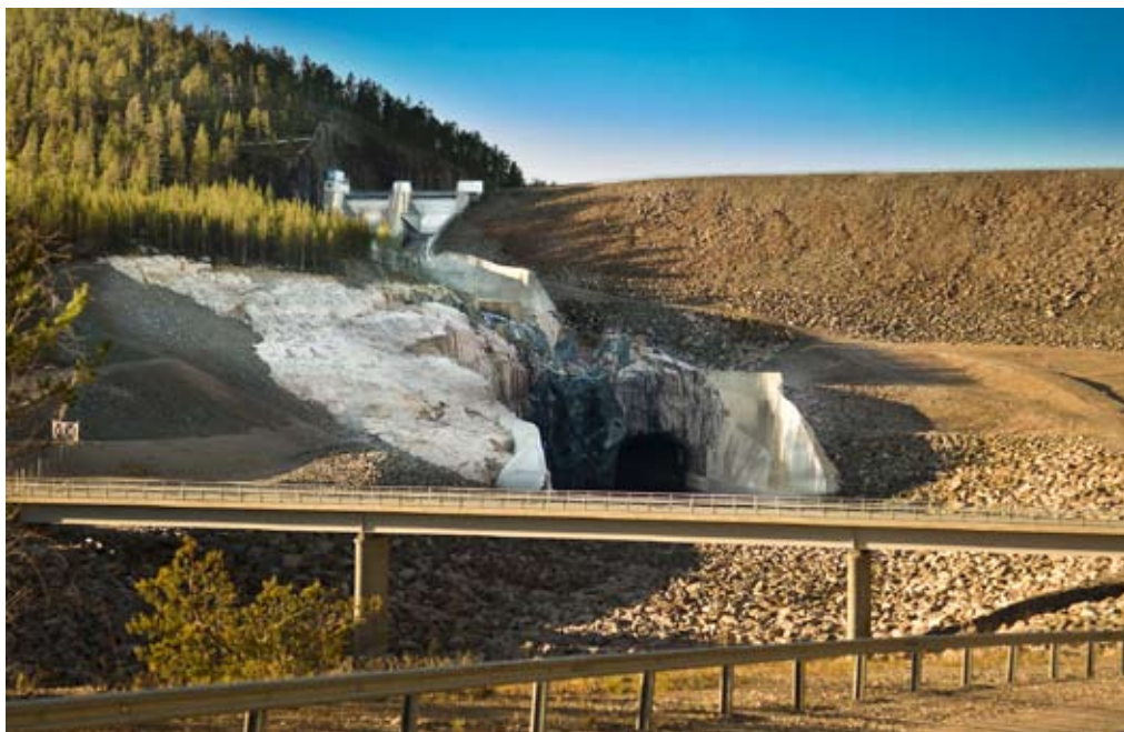
Systemet UMD 200 används vid Letsi kraftstation i Lule älv för att säkra avbrottsfri kraftförsörjning till två dräneringspumpar.
